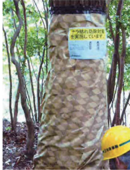
粘着テープ取付状況
