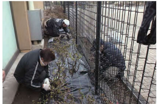
防草シート設置作業
