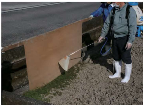
水路を被覆した除草剤散布
