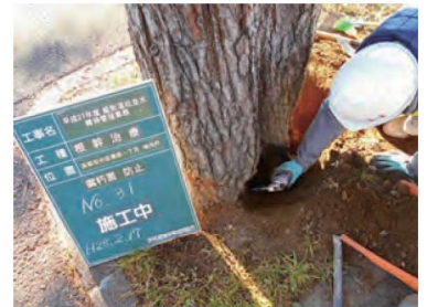
根幹治療：腐朽菌防止作業
