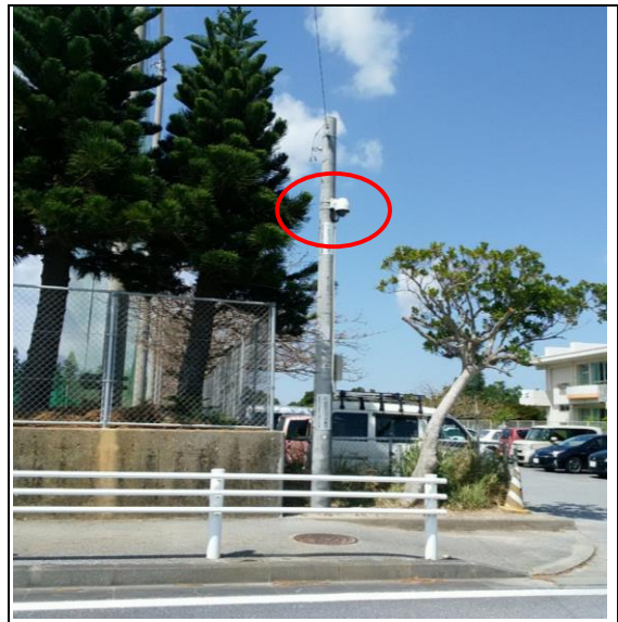
12 豊見城市字伊良波291-2 新設柱
