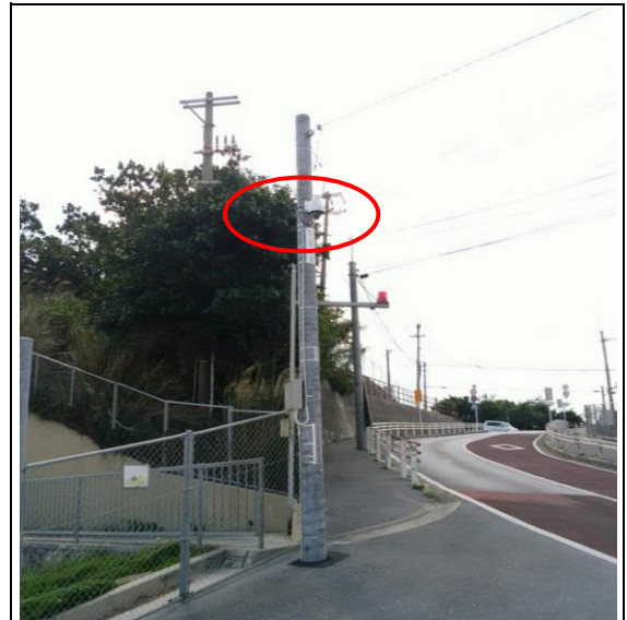
6 豊見城市字饒波1068-2 新設柱
