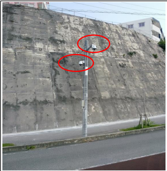
7 豊見城市字根差部564-3 新設柱
