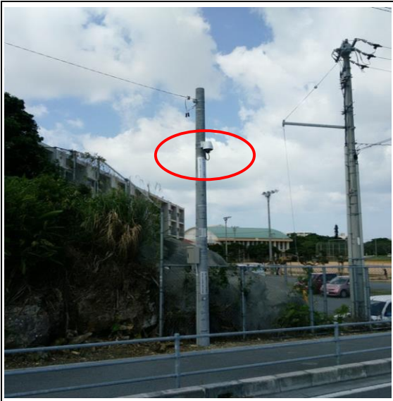
3 豊見城市字高嶺446-15 新設柱
