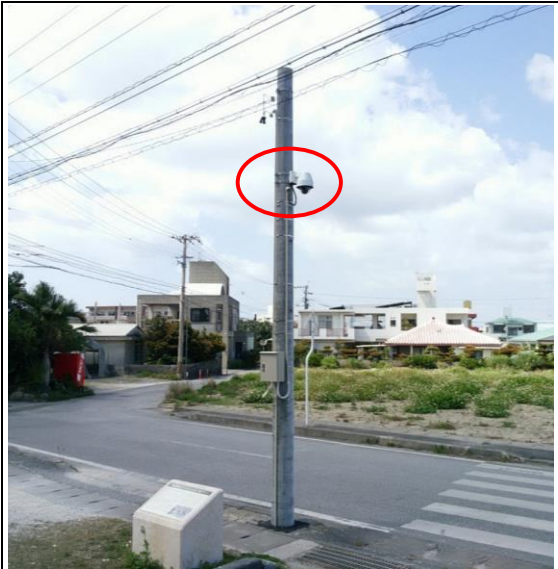
15 豊見城市字伊良波321-2 新設柱
