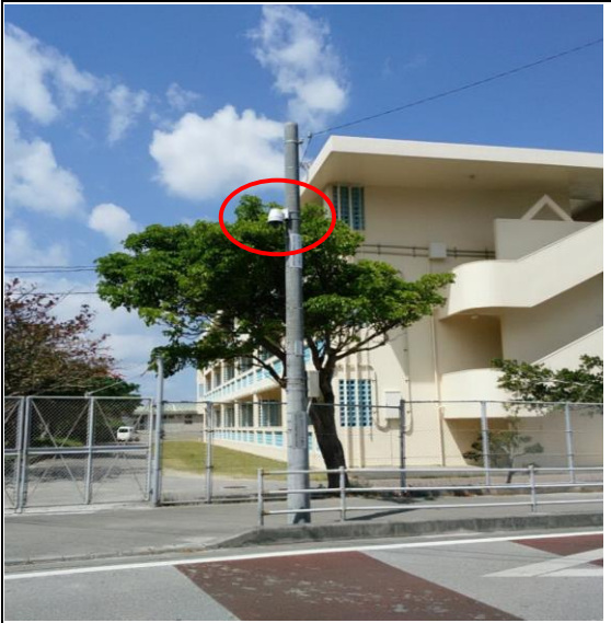
13 豊見城市字伊良波260 新設柱
