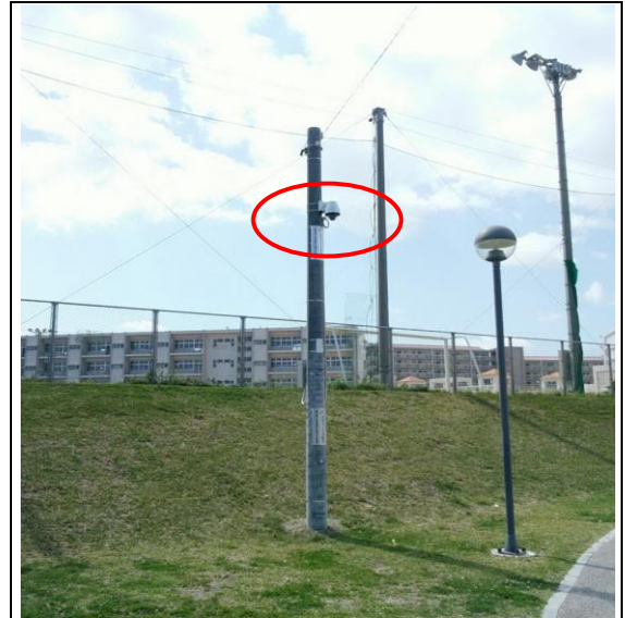
4 豊見城市字高嶺439-30 新設柱
