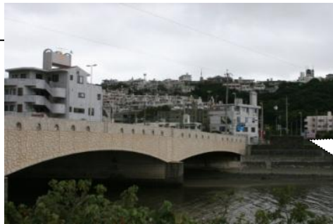
那覇市側から撮影した現在の真玉橋の様子
